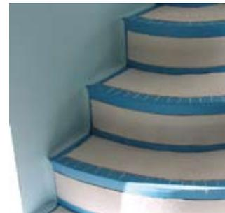
Die Abdichtung von Stehstufe und Trittstufe erfolgt in zwei Schritten:
